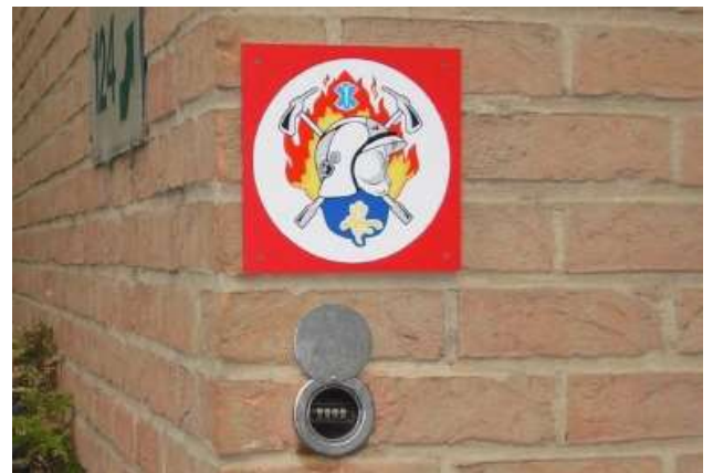
Figure 6 : Cylindre encastré avec code à roulette
